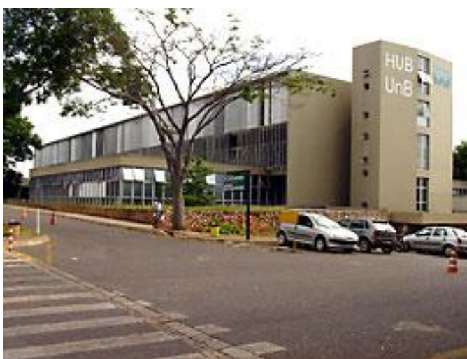
Figura 7 – Fachada do edifício do Hospital Universitário de Brasília (HUB)
