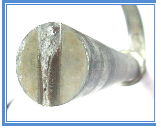
Figura 22 - Parte da manivela fracturada
