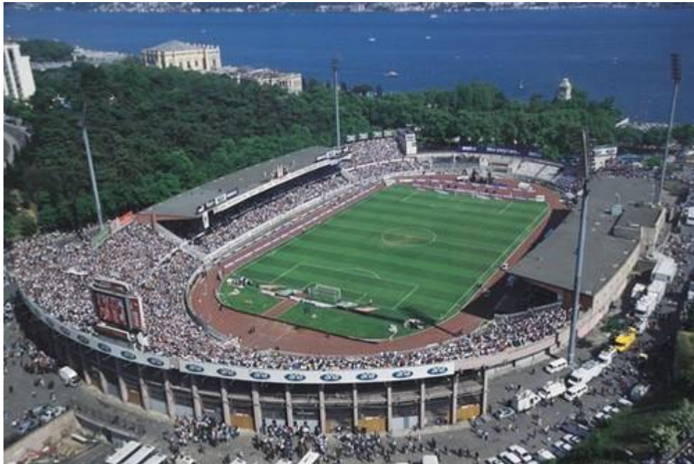
Figura 2. Estádio do Restelo
