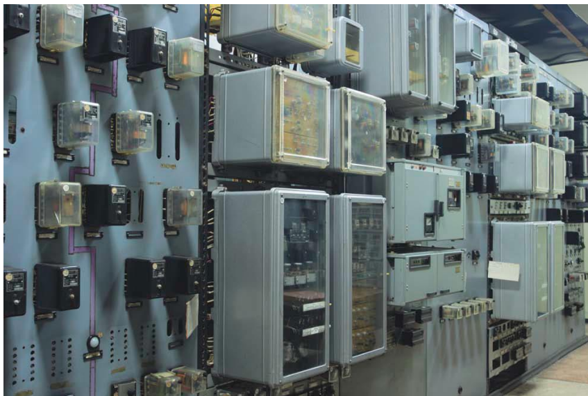
Figura 8 - Painel típico de relés
