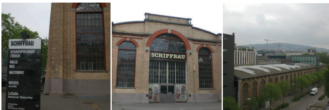
FIGURAS 15, 16 e 17 – Edifício Schiffbau , Zurique, 2011
