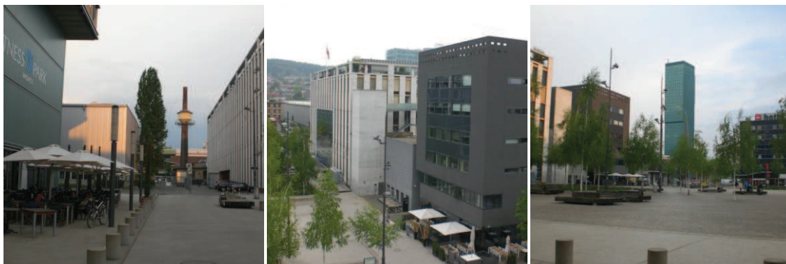
FIGURAS 25, 26 e 27 – Turbinenplatz, Zurique, 2011
