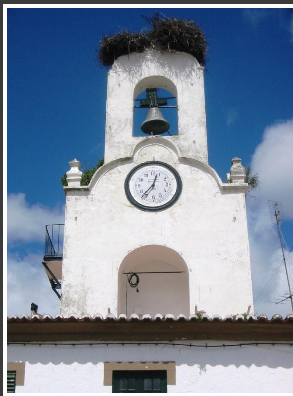
Santo Aleixo da Restauração (2005), Moura. A população resistiu aos ataques. Em 1704 a igreja foi destruída, seria reedificada em 1735.
