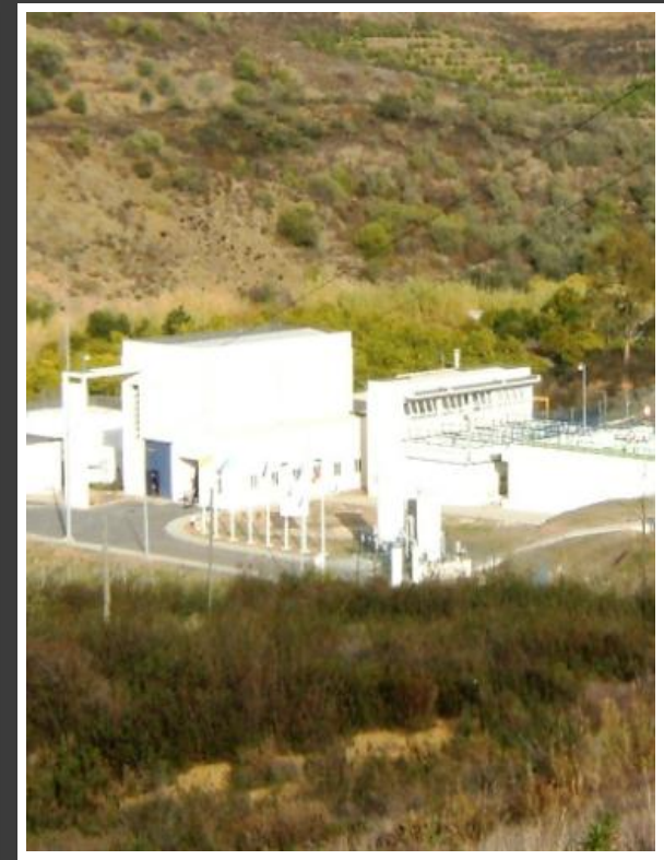
ETA do Beliche (2009) Castro Marim. A ETA do Beliche localiza-se junto à barragem com o mesmo nome. Abrange sobretudo os concelhos de Castro Marim e Vila Real de Santo António.
