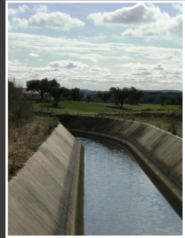
Caia (2008), Campo Maior. Canais a céu aberto para abastecer o perímetro de rega do Caia, uma das maiores e mais importantes áreas agrícolas da BHRGP.
