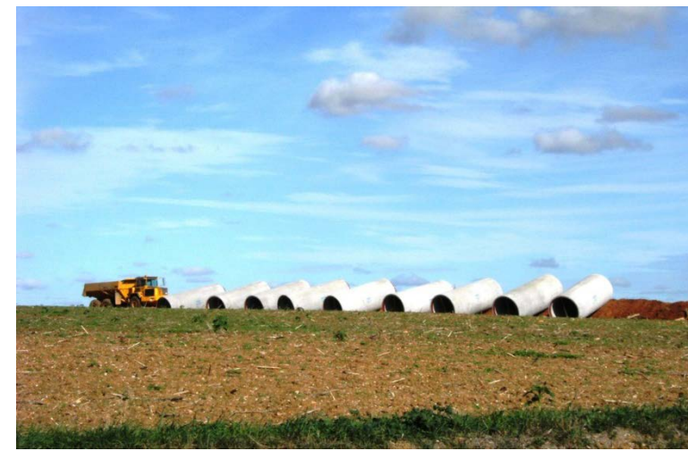
89 Durante a construção da infra-estrutura de rega do Alqueva
