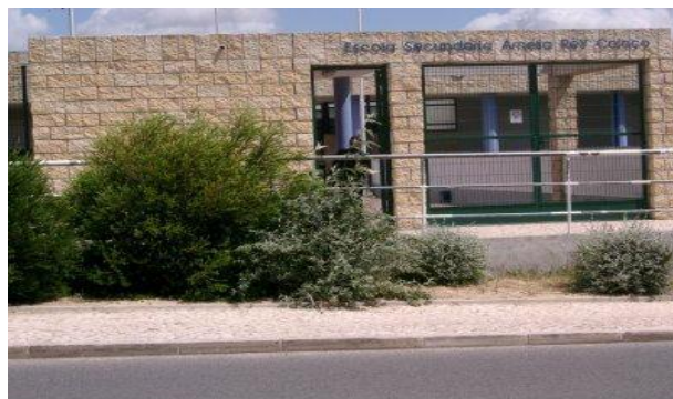
Figura 1 - Fachada da Escola Básica e Secundária Amélia Rey Colaço.
