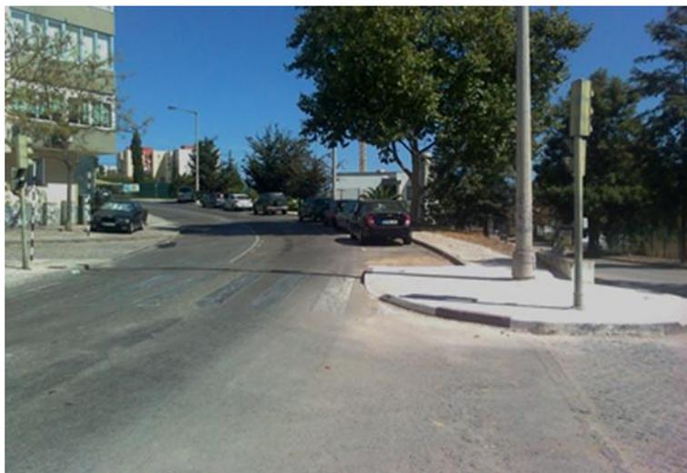
Imagem 4: Introdução de estacionamento ao longo da via, através da redução da faixa de rodagem (Fonte: Recolha própria)
